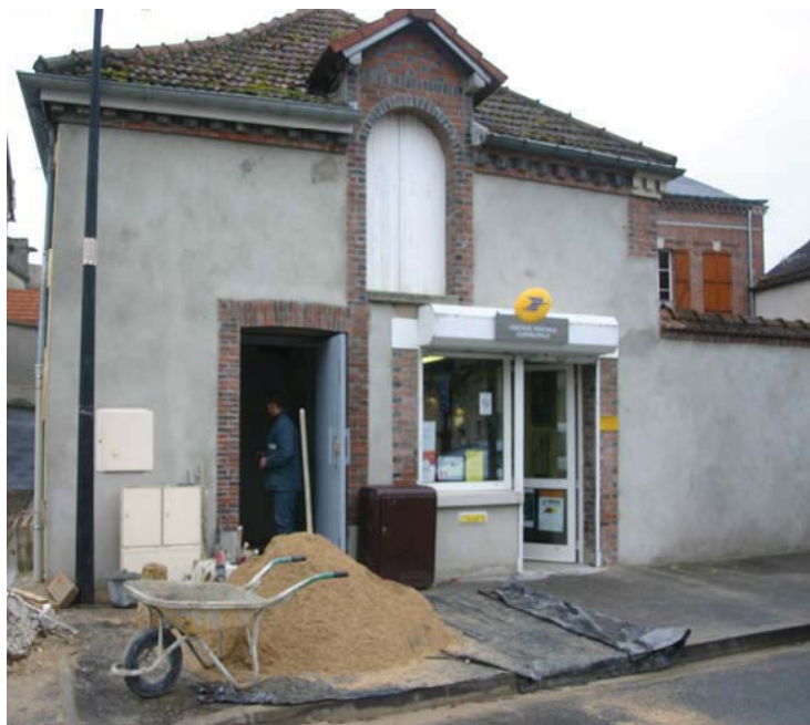
Des travaux déjà bien avancés
