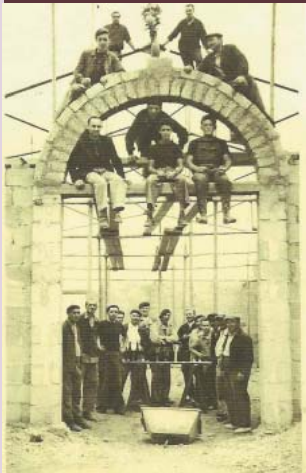
« Las d'attendre une subvention, nous avons décidé de construire nous-mêmes notre salle de gym », la commune ayant eu la bienveillance d'offrir le terrain. Après la journée de travail, 4 000 moellons ou agglos furent moulés.
