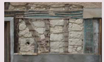
Les carreaux de terre étaient utilisés pour la construction de fours à pain. Lors de réparations, les carreaux de terre pouvaient combler des colombages en bois. Des lames de bois fendu recevaient un mortier de même nature que les carreaux de terre.
