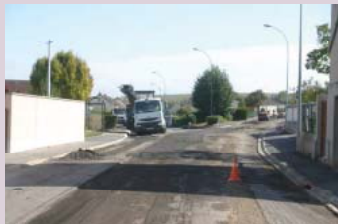
Rabotage et pose d'un nouveau tapis rue des Carrés
