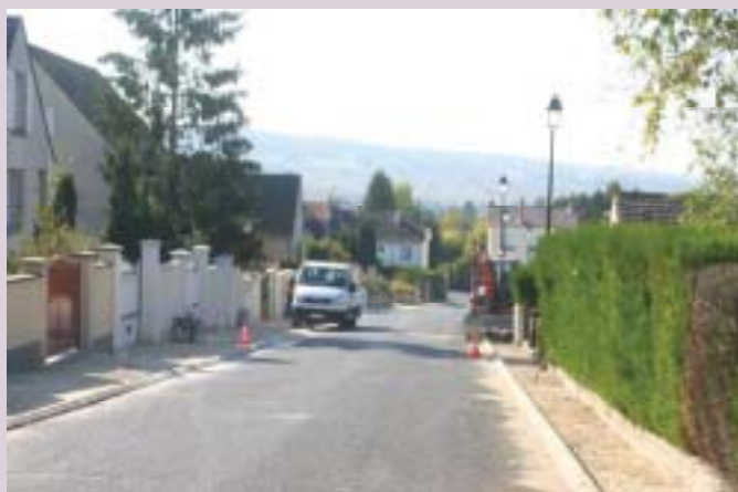
Réfection des trottoirs rue de la République
