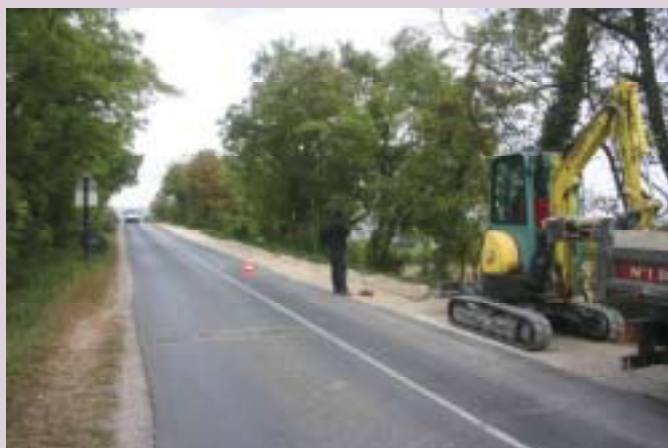
Renforcement d'une des rives des rampes du pont de chemin de fer
