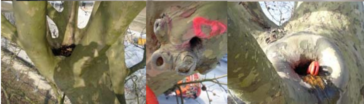
Cheminée humide qui entraîne le pourrissement
