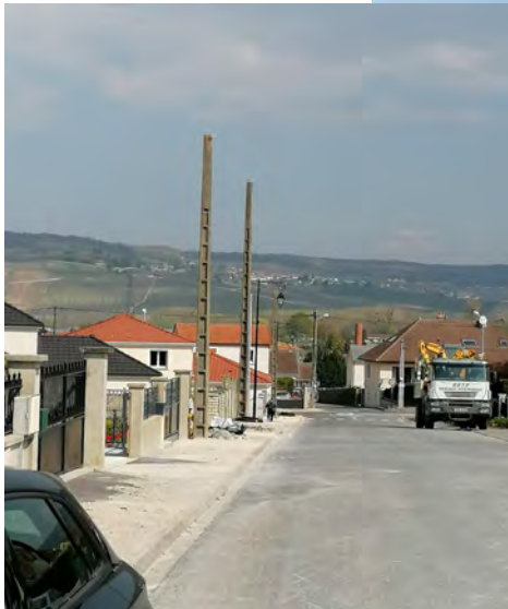
Rue des Semons enfouissement des réseaux et trottoirs rénovés
