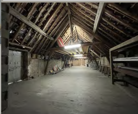
Le grenier situé en haut du garage a été désencombré
