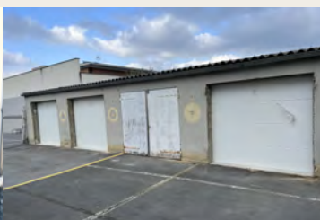
Les 4 portes de garage situées dans la cour de l'école sont changées, elles auront une ouverture électrique, l'entourage sera refait également.
