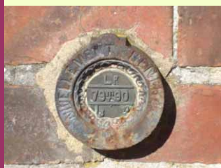
Sur la façade de l'ancien orphelinat de La Borde l'altitude gravée est 79, 90 m (vue de 1910)
