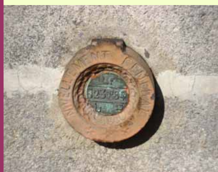
À « La Cascade », le repère est fixé à la base du bâtiment Clicquot. 123, 84 m d'altitude.
