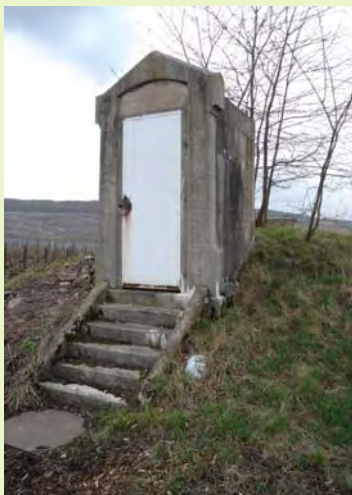
Le réservoir qui répartissait l'eau
