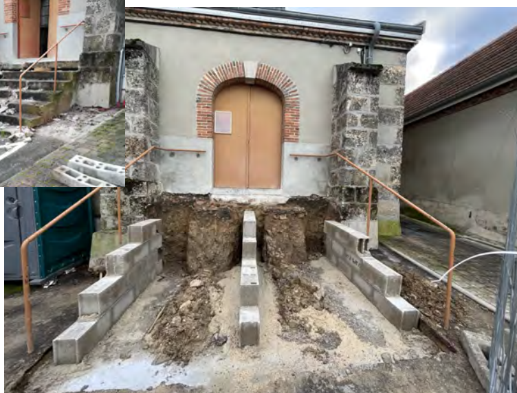
Remplacement des marches de l'église et pose d'une rampe : accessibilité du bâtiment aux Personne à Mobilité Réduite
