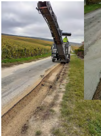
Travaux Chemin des Ronces : Reprise des accotements sur une longueur de 800 mètres
