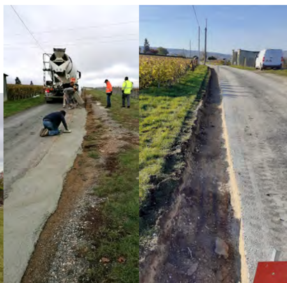
Travaux Chemin des Ronces : Reprise des accotements sur une longueur de 800 mètres
