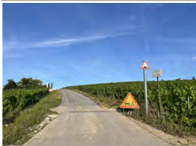
Chemin des ronces : gravillonnage et aménagement des accotements en béton
