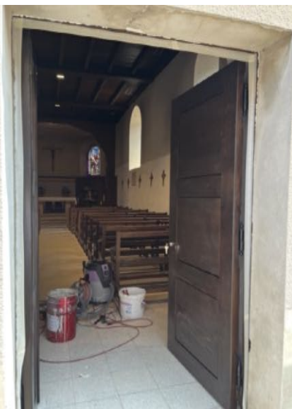
Remplacement de la porte latérale de l'église : dépose à gauche, résultat à droite. Porte sur mesure, chauffage préservé, énergie économisée
